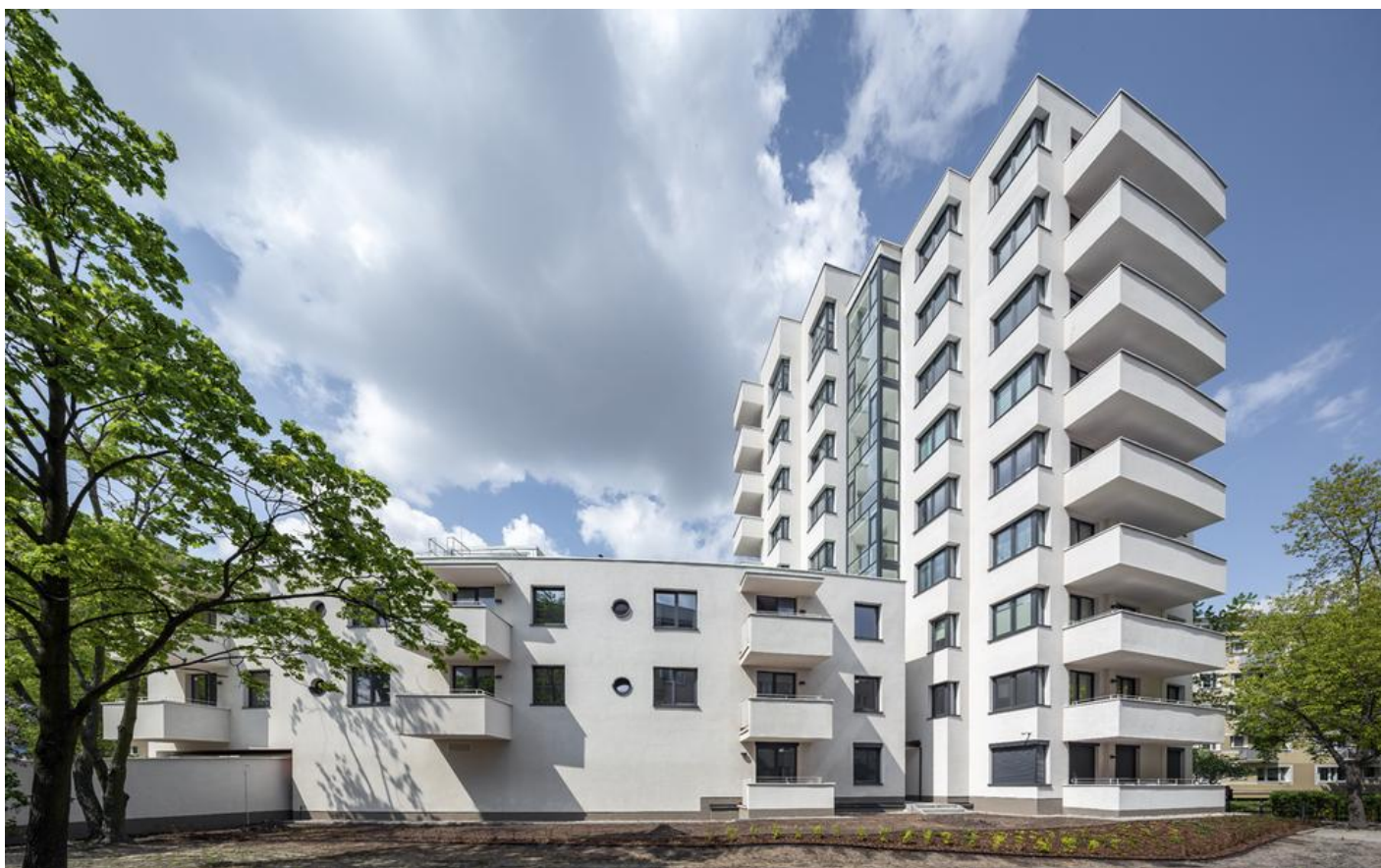
Elewacja wschodnia, widok od wnętrza kwartału. Uskokowe kształtowanie brył 10-kondygnacyjnej oraz przyjęcie 3-kondygnacyjnej wysokości w części budynku mają na celu m.in. zapewnienie właściwego nasłonecznienia mieszkań; Fot. Marcin Czechowicz
